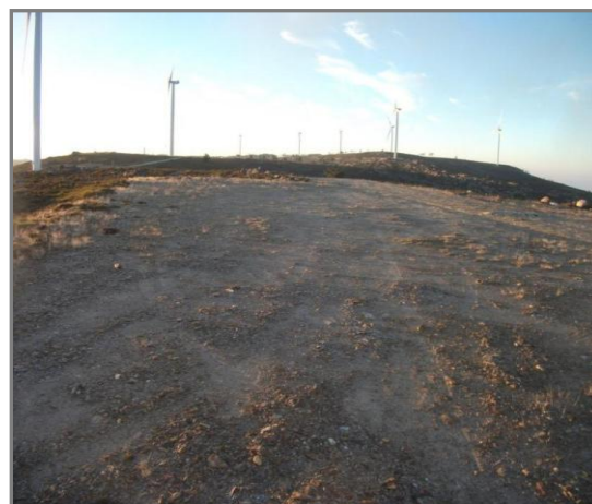
Figura 14 – Vista para plataforma do aerogerador AG10, com ausência de vegetação,
