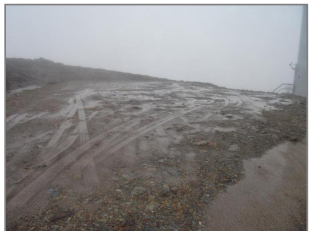
Figura 12 – Vista para plataforma do aerogerador AG 05, com ausência de vegetação,
