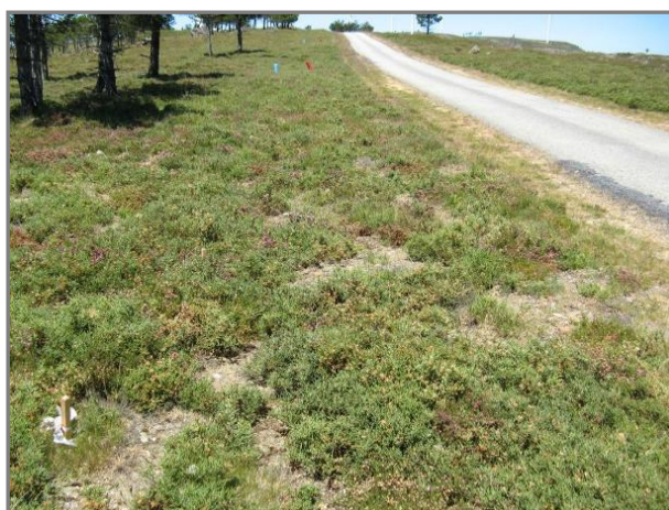
Figura 15 – Vista para vala de cabos, com desenvolvimento normal da vegetação,
